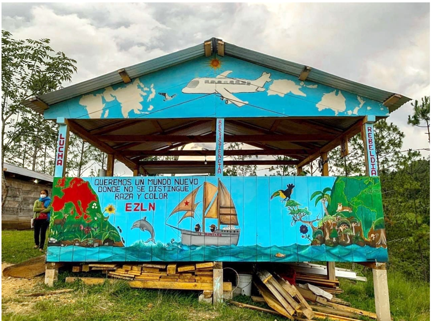
Foto: Sexta Grietas Norte
